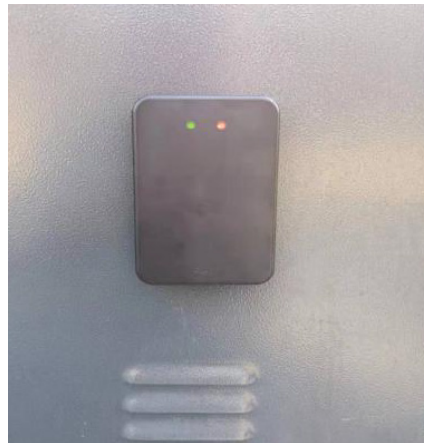
(d) Front display after installation
